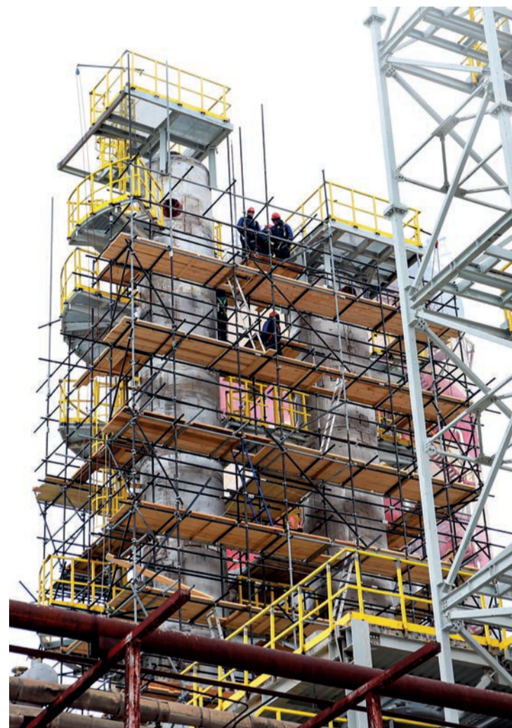
Сегодня на площадке работают около 1000 строителей
